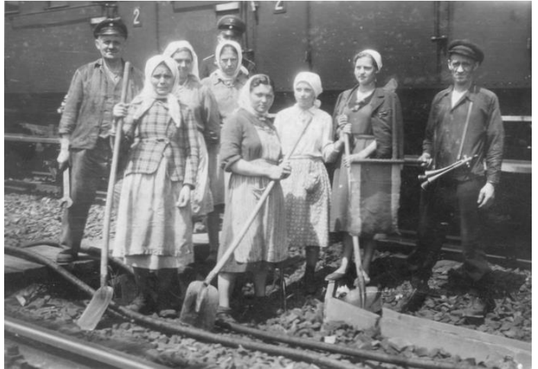
Die Eisenbahnen sind kriegswichtig, sie transportieren Waffen, Lebensmittel - und Menschen. Diese ukrainischen Arbeiter bessern für die Reichsbahn an der Bahnlinie Hamburg-Berlin zerstörte Gleise aus. Das Bild stammt vermutlich aus dem Jahr 1944.
